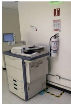
Fuente: Evidencia Oficina de Control Interno
