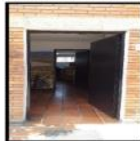
Puerta de acceso a oficina de almacén y bodega auxiliar
