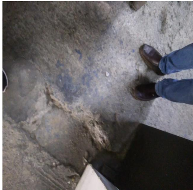
Imagen No. 10 Pisos Fuente: Bodega Almacén IDPAC
